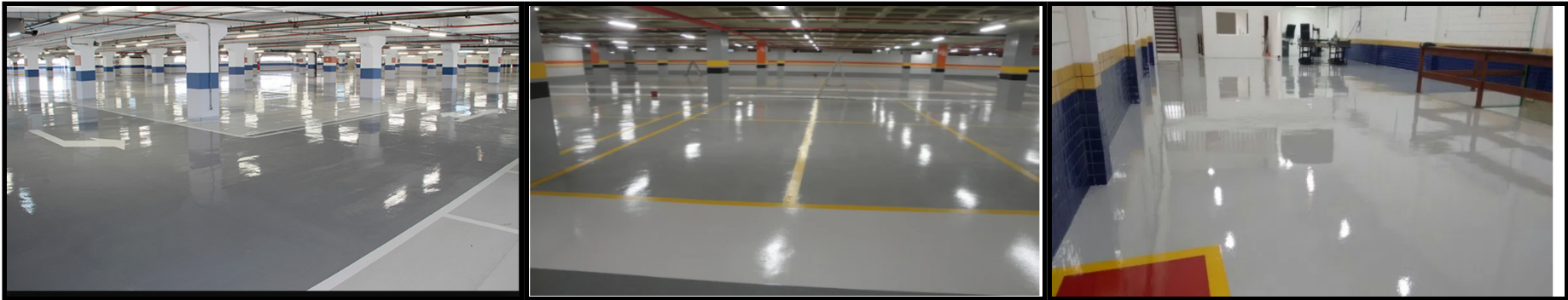
Fotos 07, 08 e 09 - Exemplos de Pisos Epóxi para garagens
