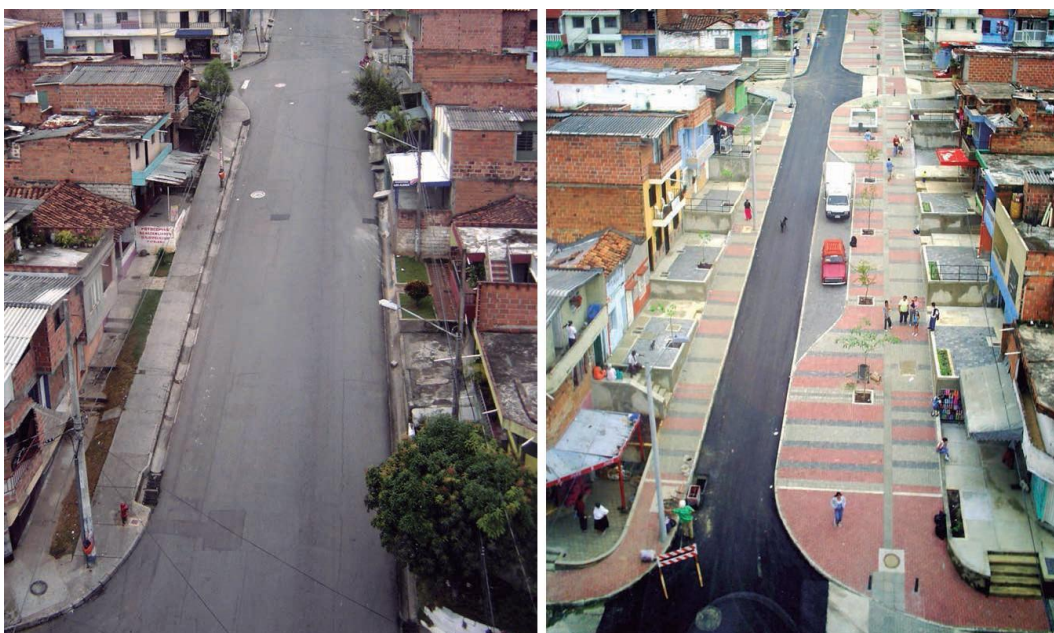
Figura 38: Antes x Depois da Calle 107 – exemplo de qualificação de calçadas com estacionamento ao longo da via e estreitamento de faixas, Medellín (Colômbia)
