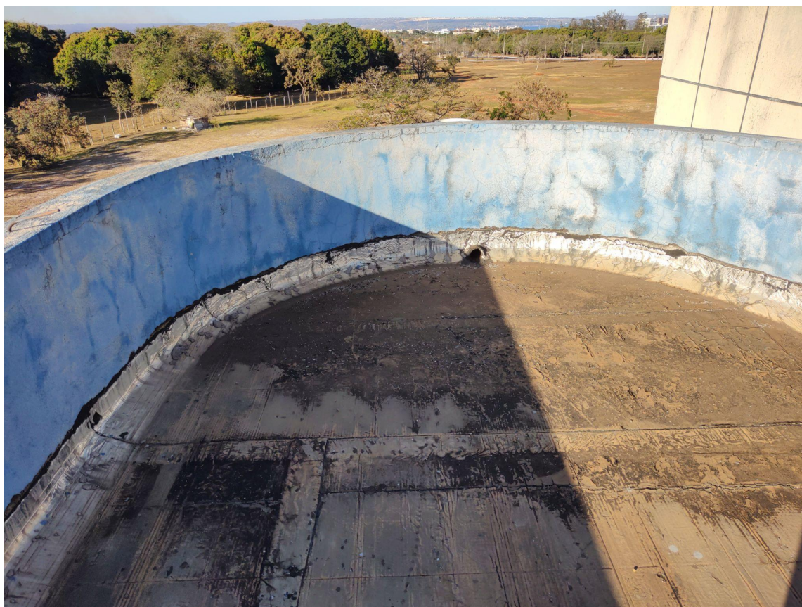
Figura 5: manta deteriorada causando infiltração
