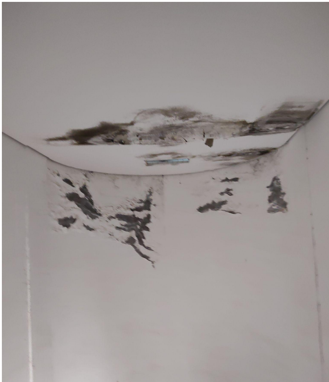
Figura 8: forro de gesso acartonado danificado pela infiltração
