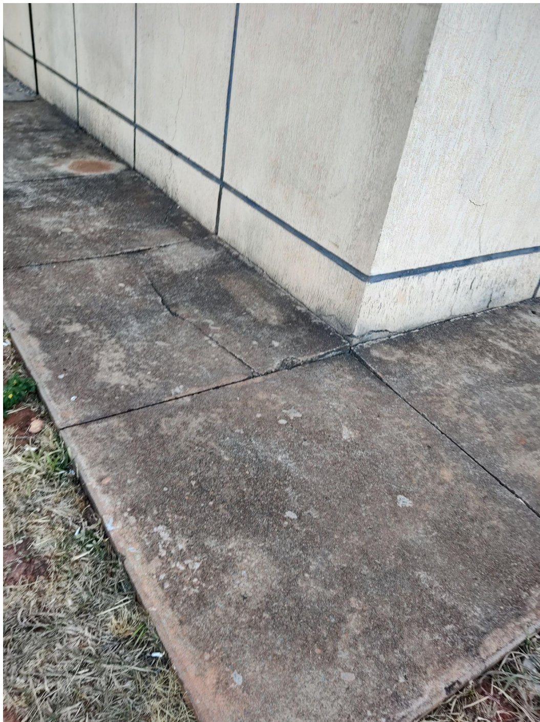
Figura 4: trincas de recalque na parede e calçada
