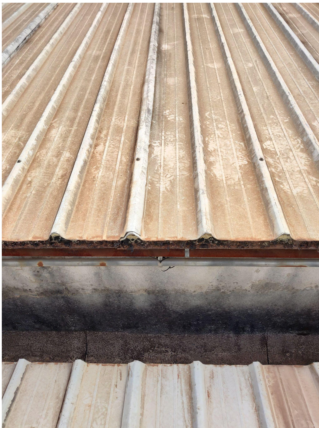
Figura 6: calha sem impermeabilização
