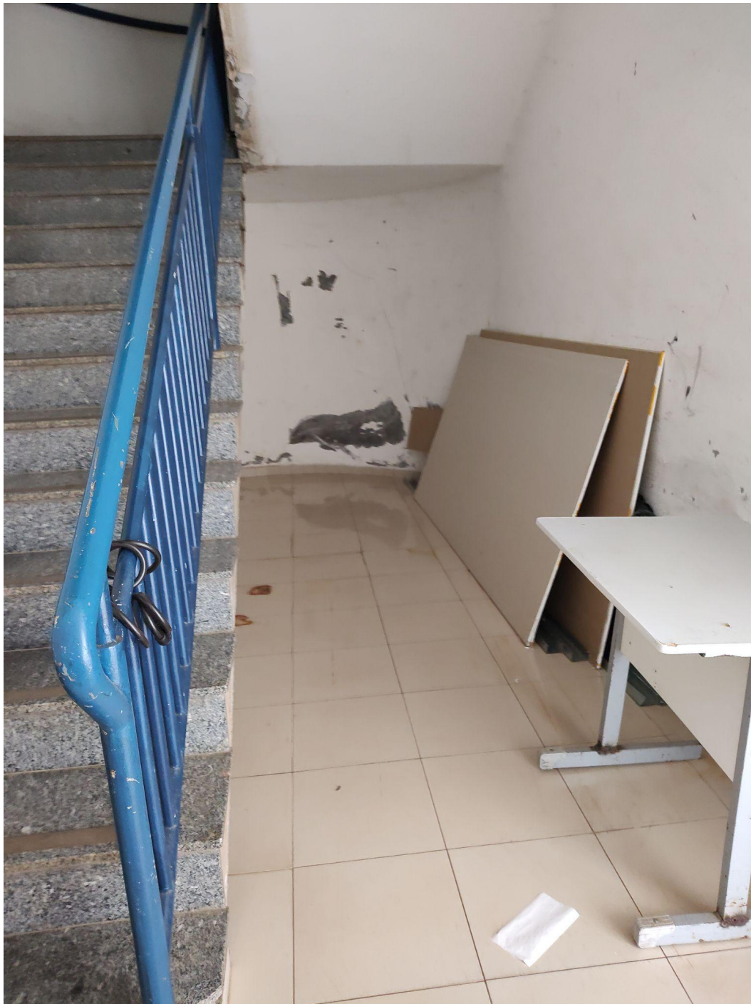
Figura 10: parede com infiltração e estrutura metálica com pintura precisando de reparos
