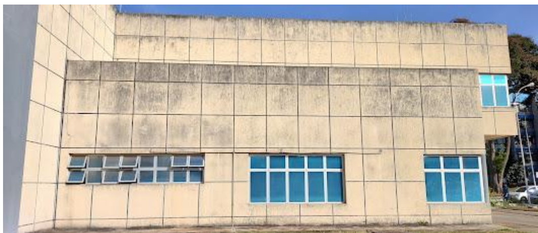
Figura 2: fachada lateral esquerda - manchas no grafiato
