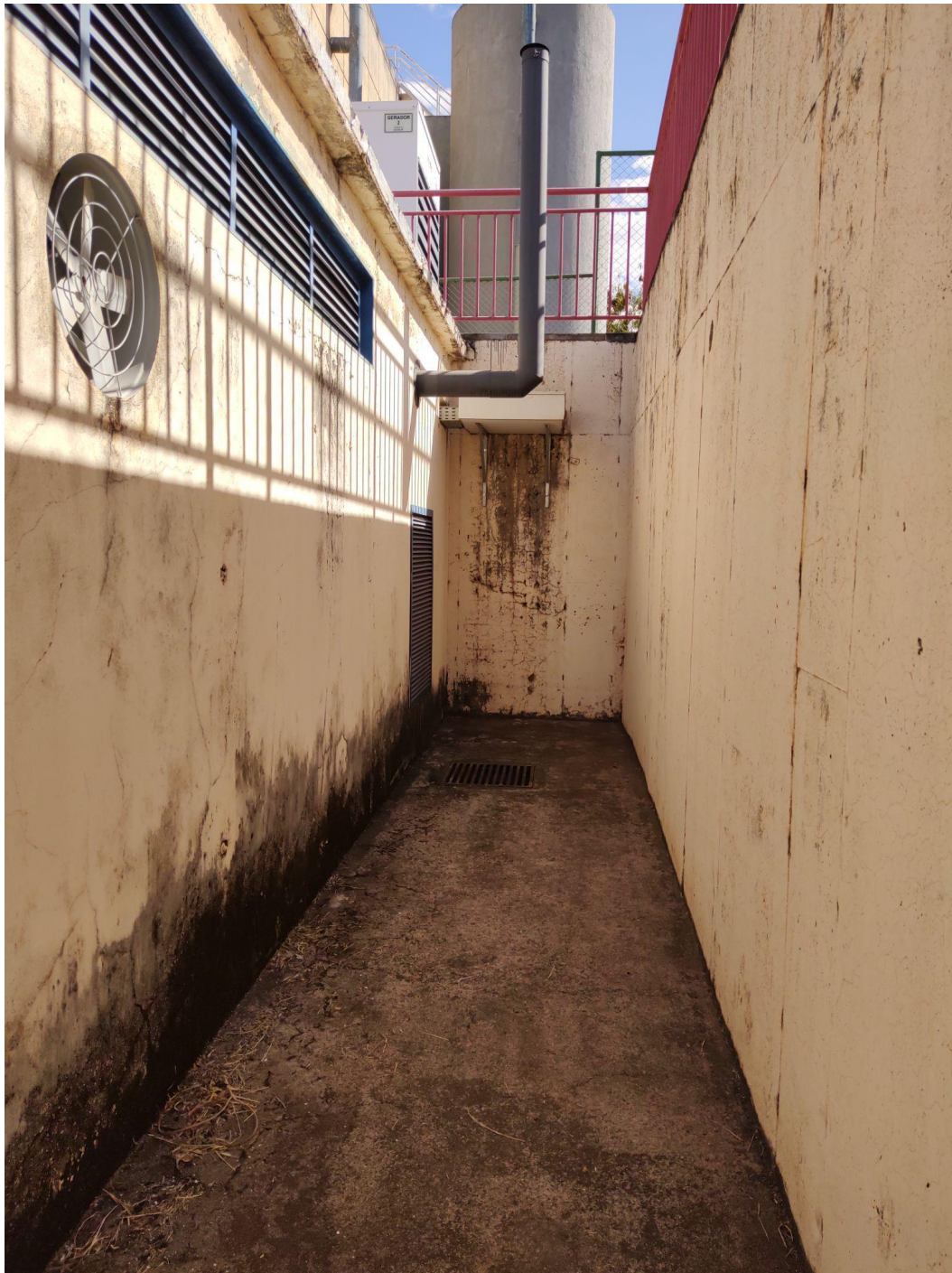
Figura 12: área externa da subestação necessitando de pintura
