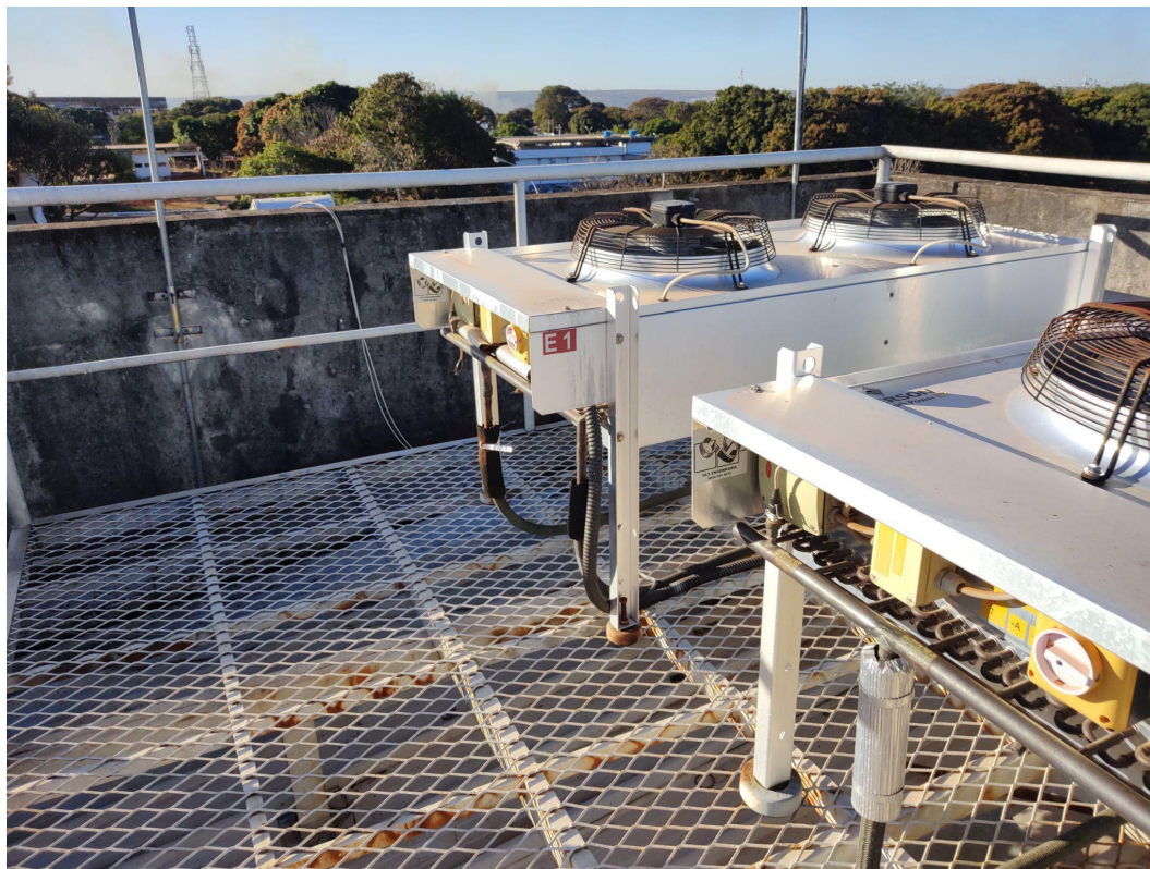
Figura 7: ferragem da estrutura metálica na cobertura oxidada
