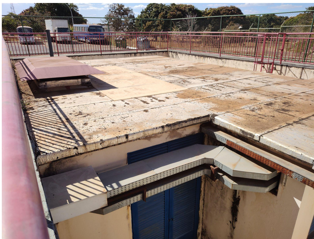
Figura 11: manta da cobertura danificada
