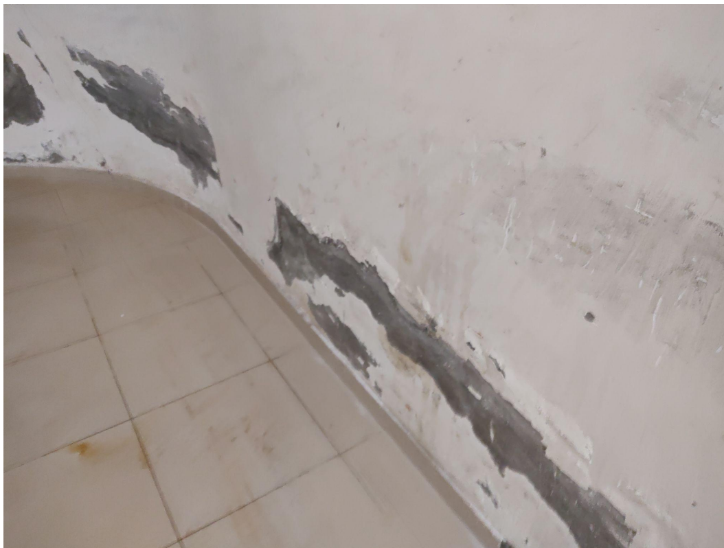
Figura 9: parede com infiltração
