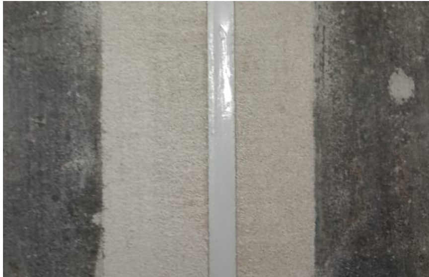
Figura 13: Acabamento final desejado das juntas de dilatação
